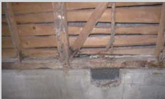
タイルのお風呂の場合、漏水が原因で構造材が腐朽しているケースが多いです。ユニットバスの工事と合わせて交換工事を行います
