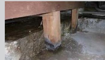
床下の漏水を放置すると床下の水分量が増加し、木材の腐朽や蟻害を引き起こす原因となります。
