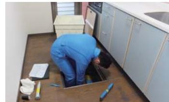
台所の床下収納庫を外して床下へ進入調査をいたします。床下調査ができない場合はかし保険やフラット35を利用することができます。
