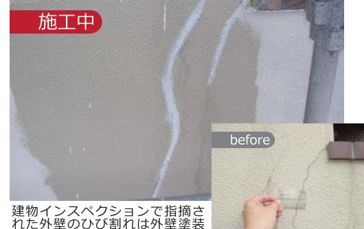
建物インスペクションで指摘された外壁のひび割れは外壁塗装とあわせて補修しました。
