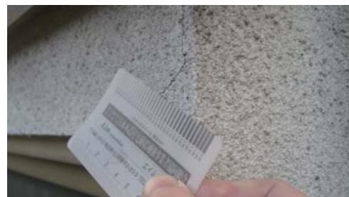
外壁のひび割れを計測しています。
