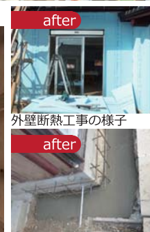
基礎の増し打ち補強
