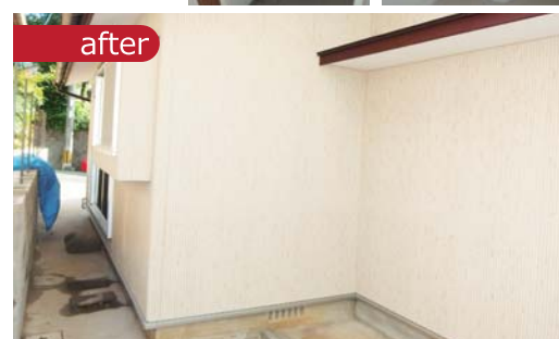
カバー工法で綺麗になった外壁
