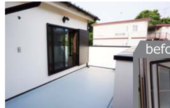
↑手すりがなく危険だったバルコニーを防水施工とともに改修。
