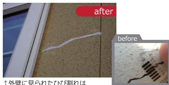
↑外壁に見られたひび割れは 売主様に補修していただきました。
