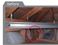
↑ 小屋裏調査の様子。赤丸部分に筋交い(構造材)の端部が確認できます。
