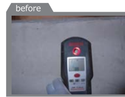
↑ 基礎の配筋検査の様子。専門機器で非破壊調査を行います。
