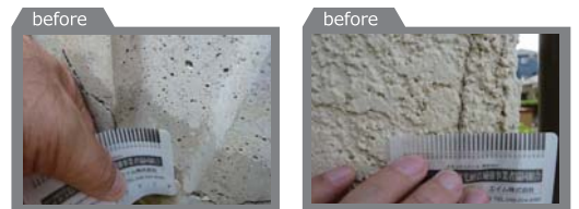
建物インスペクションで指摘された基礎と外壁のひび割れ。いずれも軽微な工事で補修できました。
