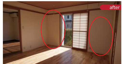
赤丸が壁補強を行った箇所。天井・床の解体を含む工事だったので、元々和室だったのですが、洋室への変更も合わせて行いました。
