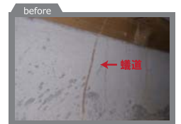
調査で発見された蟻道（シロアリ）の形跡。シロアリ消毒を実施しました。
