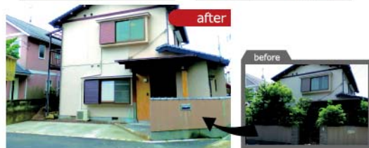
外構改修で駐車スペースを新設しました
